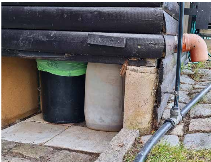
Så här enkelt går det att ordna en luktfri toalett där besökaren sitter inomhus på en porlinsstol. Om urinen leds bort i ett rör till en nedgrävd tank är det bara tunnan som behöver regelbunden passning. Räkna med 0,5 liter per person och dygn i tunnan så kan du räkna ut tömningsintervallet för din storlek på tunna. Foto: Gunnar Eriksson.
